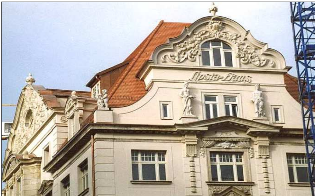
Neugestaltung historische Gaube nach ursprünglichem Original
